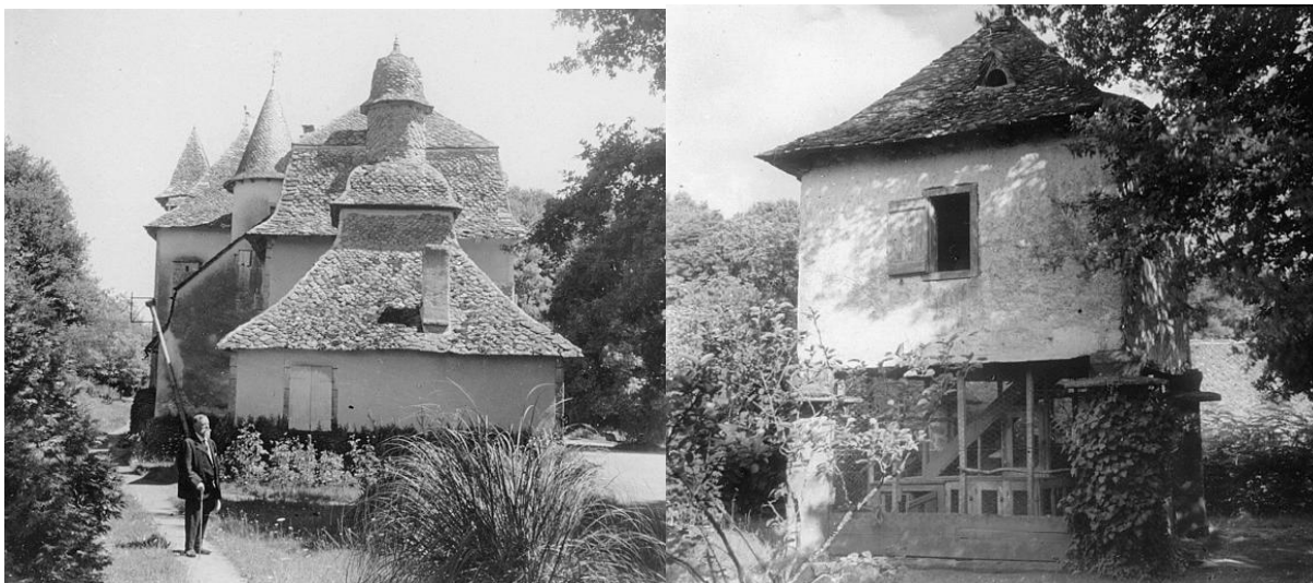
Figure 20 - Château du Bac, Argentat-sur-Dordogne. Façades et toitures du château et de son colombier inscrits MH ©Ministère de la Culture (France), Médiathèque de l'architecture et du patrimoine, diffusion RMN-GP
