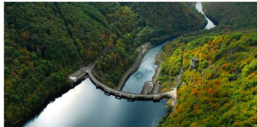
Le barrage du Chastang Servières-Le-château
