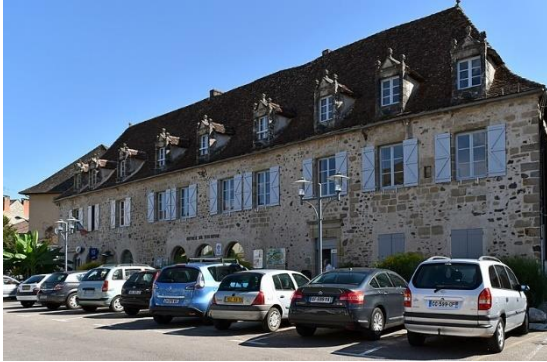
Figure 30 - Immeuble du Bessol, inscrit MH en 1949 ©Père Igor
